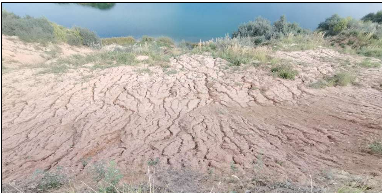
Рисунок 1 – Ручейковая сеть на пологом откосе карьерной выемки в южной части участка «Гралево» месторождения доломита «Руба»
